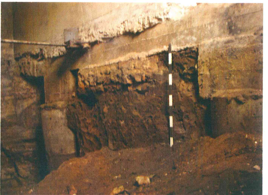
20. Rūsio I patalpa. Kolonos po pertvarine siena
