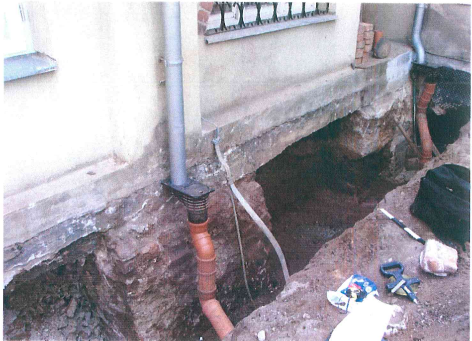
8. V fasadas PV dalis. Rūmų pamatai.
