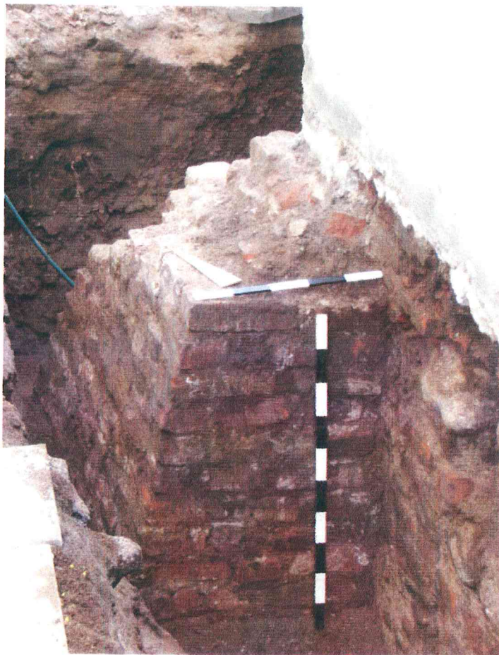
3. P fligelio pamatai iš P. Kontraforsas
