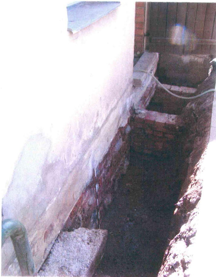
1. P fligelio P sienos pamatai iš PV
