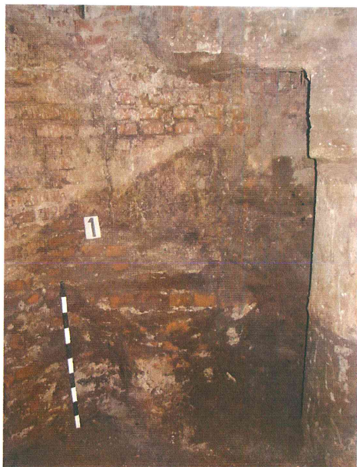
17. I rūšio patalpa. Esamo rūšio R sienos pamatai ir atraminė kolona
