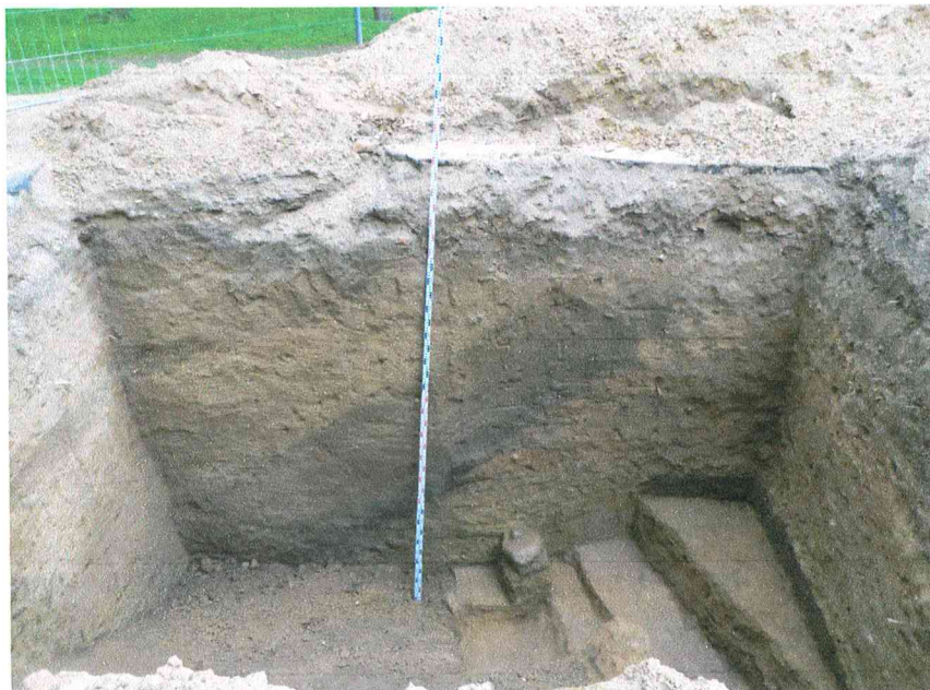
49. Praplatintas šurfas Nr.40, g.3,5 -4,0 m, PV sienelė, iš ŠR pusės
