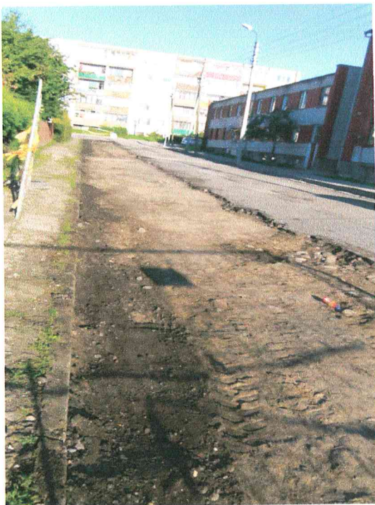
72. Karaimų g. , nuėmus asfaltą, iš R pusės
