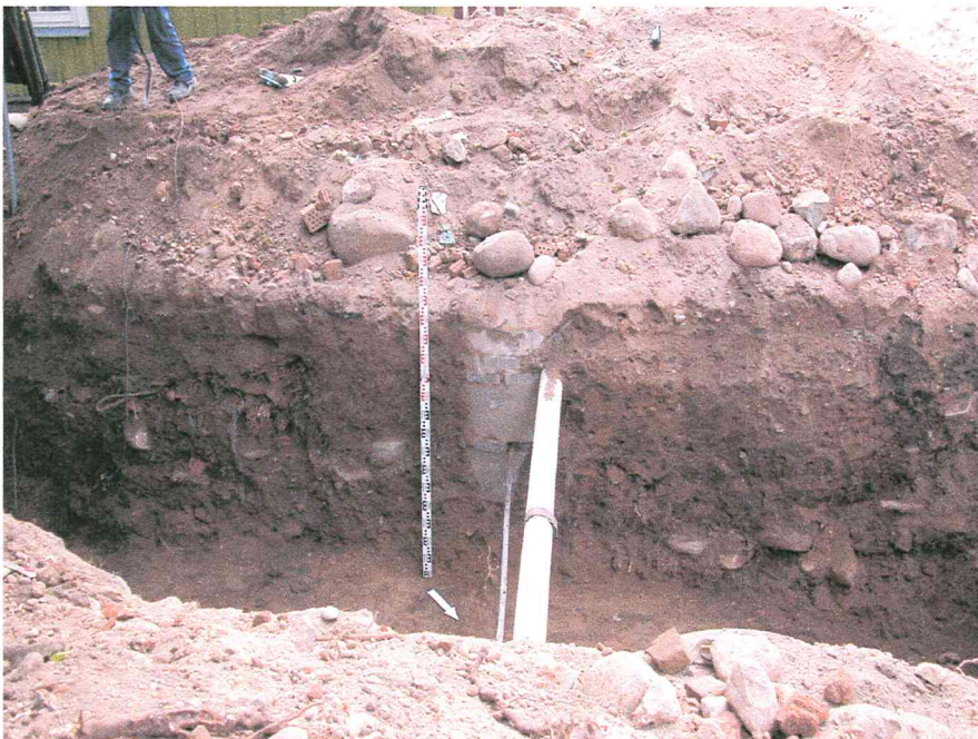
Nuotr. Nr.69. Lietaus nuotekynės trasa Nr.1. PV sienelės pjūvio G-G1 fragmentas. Fotografuota iš ŠV pusės.
