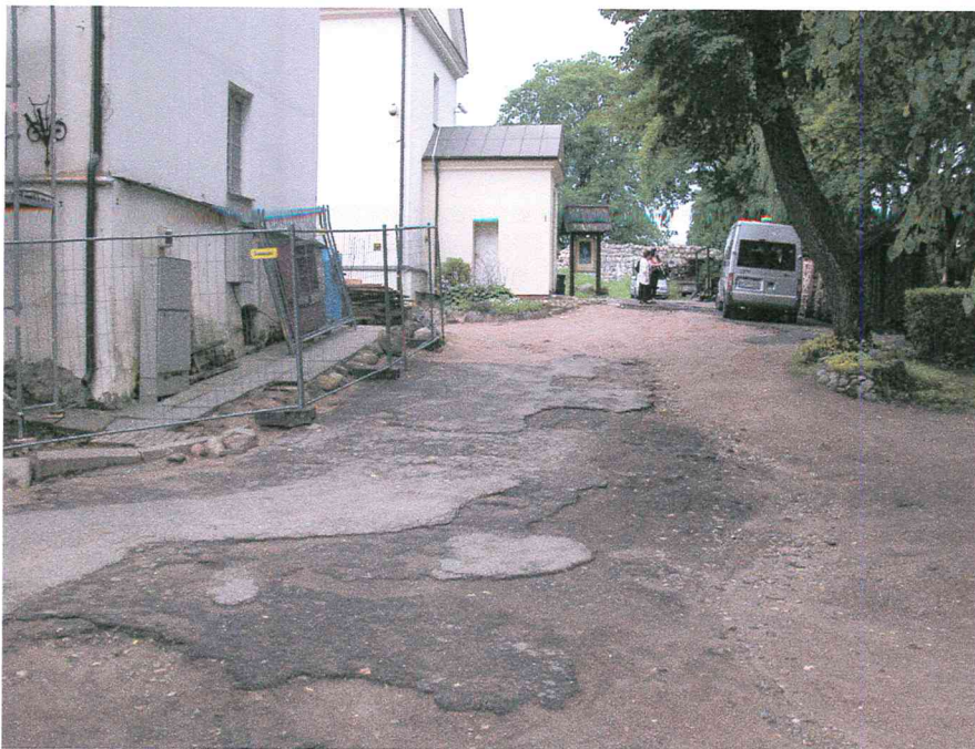
Nuotr. Nr.1. Archeologinių tyrimų vieta – Trakų pusiasalio pilis bei Dominikonų vienuolynas. Kiemo vidus, fotografuota iš P pusės.
