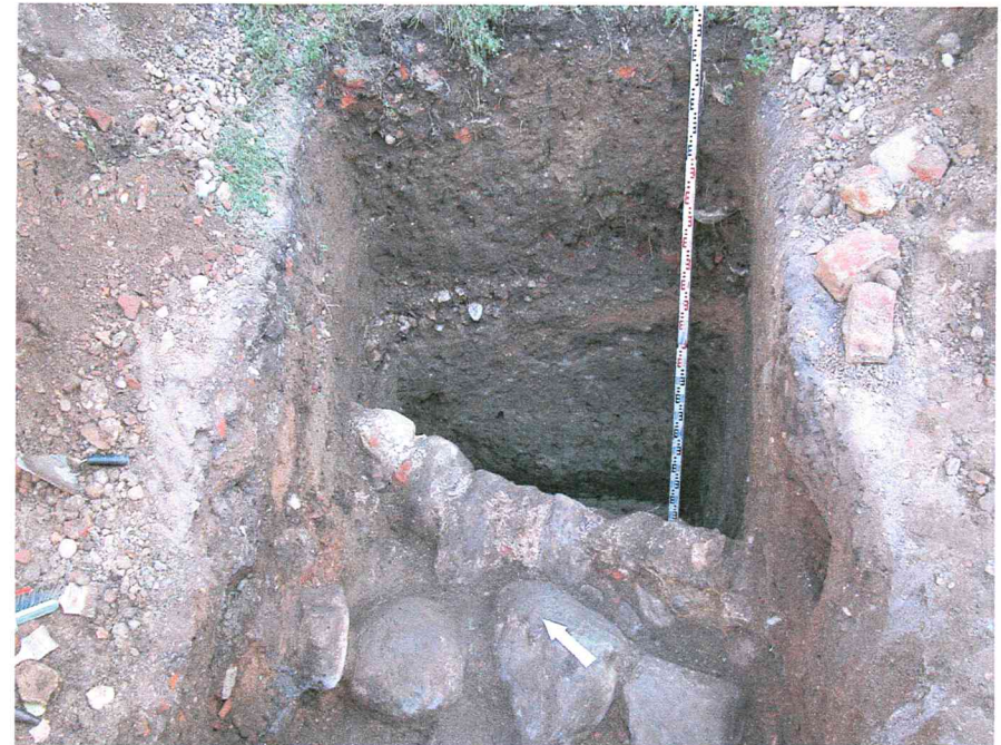
Nuotr. Nr.61. Lietaus nuotekynės trasos Nr.1 išpjova A (kv.G31-33 - J31-33). ŠR sienelės pjūvis D-D1.
