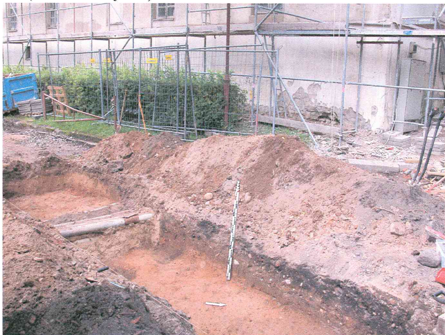
Nuotr. Nr.42. Perkasos Nr.4. ŠV sienelės pjūvis A-A1. Fotografuota iš PR pusės.
