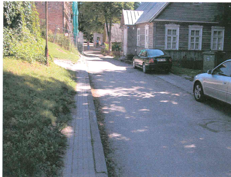
Nuotr. Nr.119. Elektros kabelių trasų vietos prieš tyrimą. Šalia Karaimų g. 5 namo.
