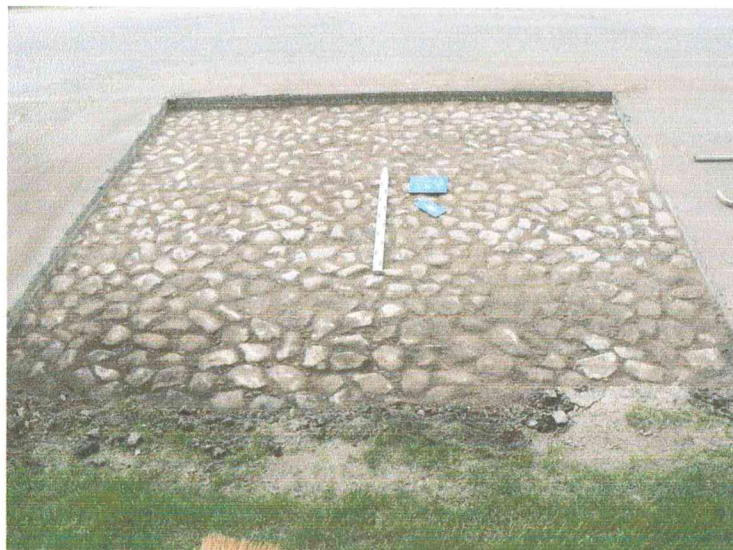
Šurfas Nr. 32, gatvės grindinys (fotografuota iš ŠR pusės)
