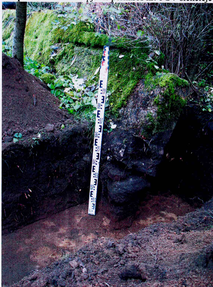
11 pav. Betono ir plytų siena ir jos pamatas iš nerištų lauko riedulių perkastos nr. 1 PV gale PR sienelėje
