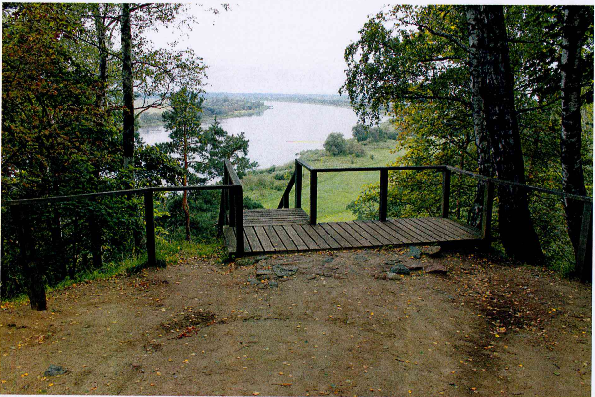
F.2. Mechaninė erozija kalno aikštelėje. Vaizdas iš R.
