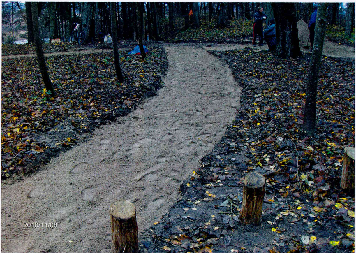
F.9. Įrengiami takai – užpiltas žvyro pasluoksnis, vaizdas iš ŠR.
