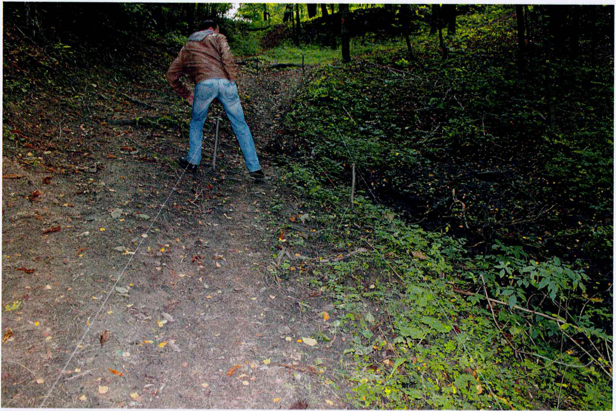
F.11. Nužymėti būsimųjų medinių laiptų kontūrai, vaizdas iš PV.
