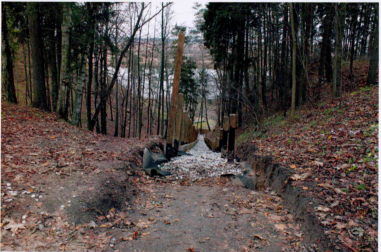
F.14. Statomi laiptai – į grėžinius sukalti kuolai, prie jų prikaltos sijos, tarp jų ant geotekstilės užpiltas gargždas. Vaizdas iš Š.
