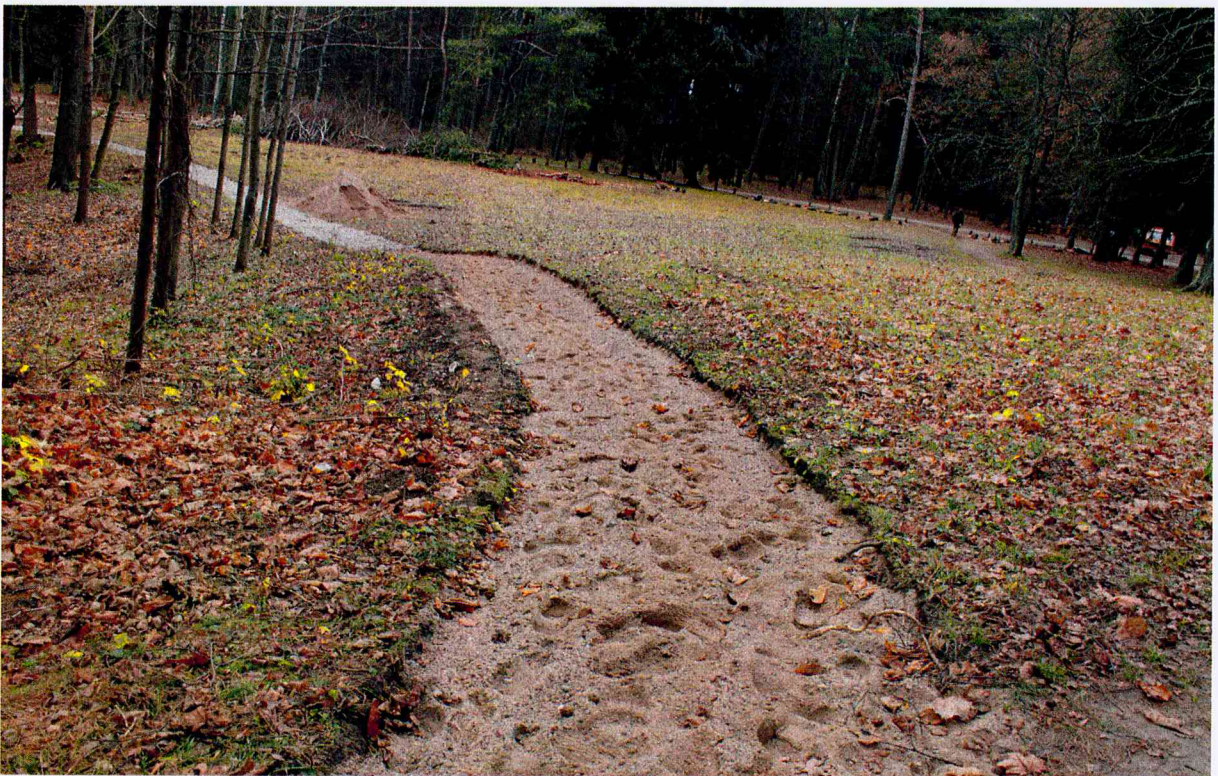
F.10. Įrengiami takai - ant žvyro pasluoksnio užpilamas gargždas, vaizdas iš PR.
