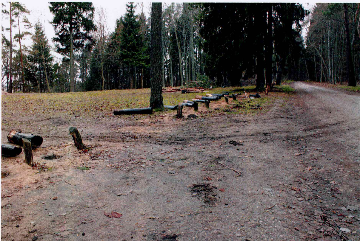
F.19. Kelio atitvėrimo stulpeliai keičiami naujais, vaizdas iš R.
