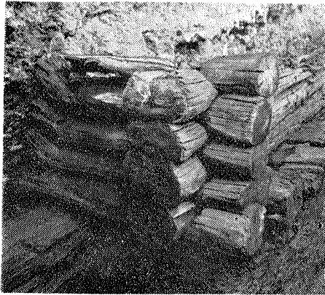
2 pav. Pastato Nr. 13 pietinis kampas. Pietvakarių sienos rąstai remiasi į vėlyvesnio mūrinio pastato pamatus
