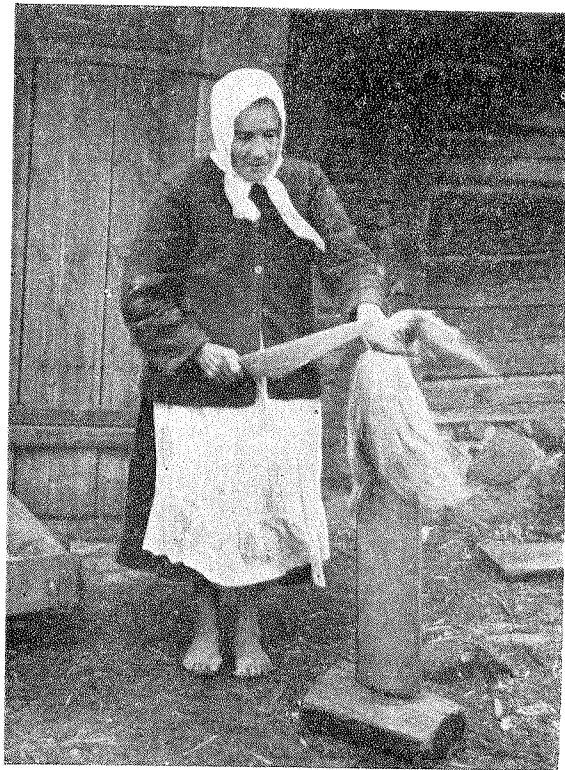
10 pav. Linai brukami vienaasmene bruktuve Pandėlio raj., Jonavos vnk.
