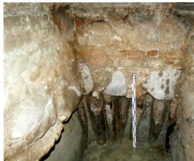
12 pav. Medinės pamatų konstrukcijos, rūmų W rūsys. P. Blaževičiaus 2006 m. tyrimai. Vaizdas iš vakarų pusės. V. Abramausko nuotr.
