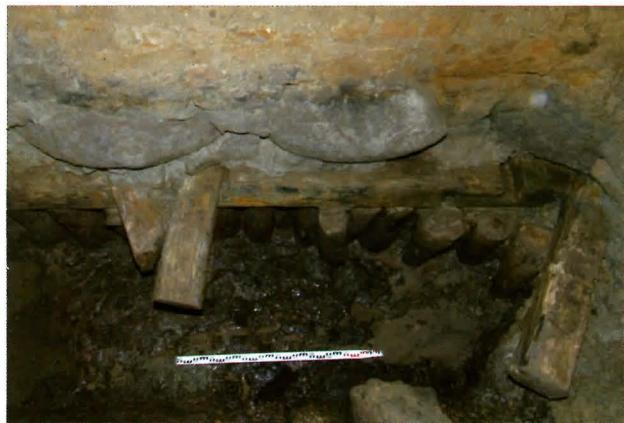
10 pav. Medinės pamatų konstrukcijos, rūmų C rūsys. E. Ožalo 2006 m. tyrimai. Vaizdas iš pietų pusės. V. Abramausko nuotr.
