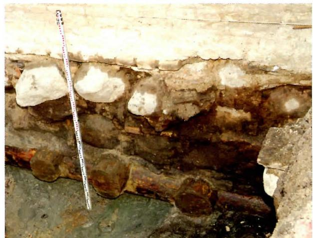
15 pav. Medinės pamatų konstrukcijos, rūmų M rūsys. E. Ožalo 2004 m. tyrimai. Vaizdas iš šiaurės. V. Abramausko nuotr.
