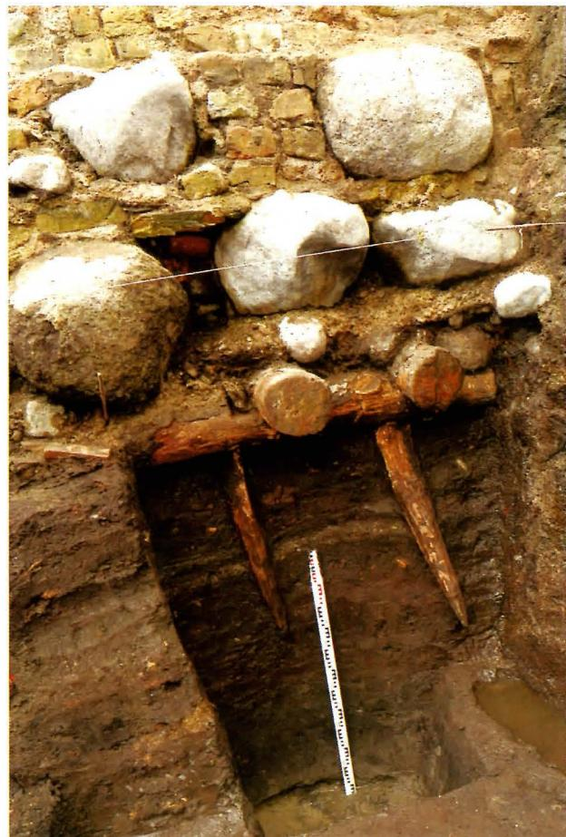
11 pav. Medinės pamatų konstrukcijos, Radvilų kiemo atitvarinė siena. D. Steponavičienės, P. Blaževičiaus 2005 m. tyrimai. Vaizdas iš rytų pusės. V. Abramausko nuotr.
