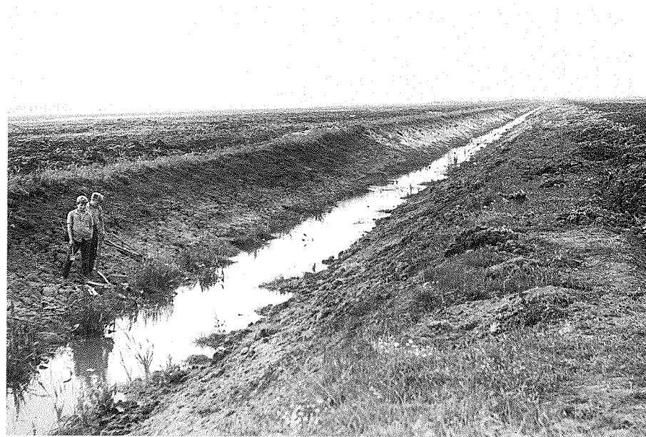
2 pav. Šventosios melioracijos kanalas 1967 m. pradedant 2-osios radimvietės tyrinėjimus
