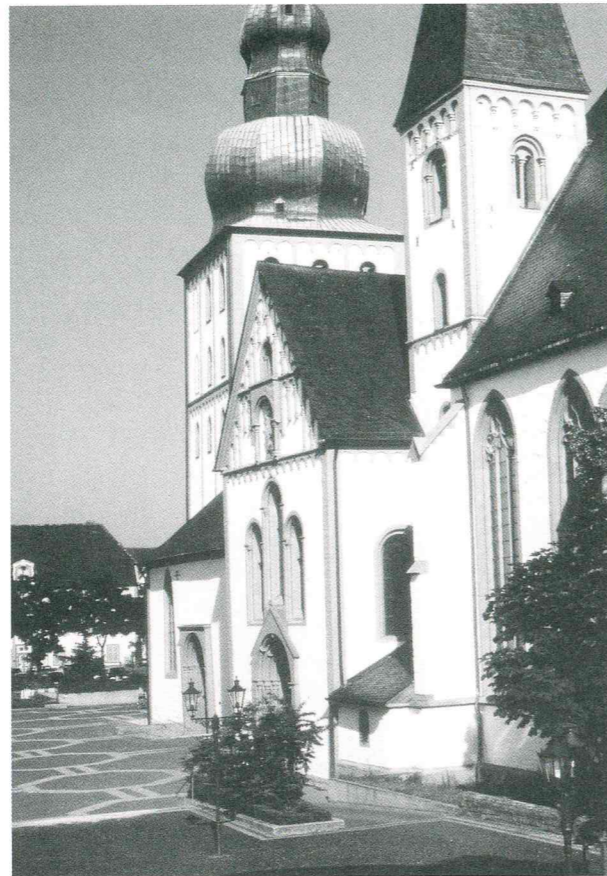
Abb.13 . Lippstadt, Marienkirche. Vor 1222. Geweiht durch Bernhard II. zur Lippe. Ansicht von SO. Westturm, Schiff, Südtransept und eingestellter SO-Turm vom Gründerbau. Chorerweiterung Ende 15. Jahrhundert
