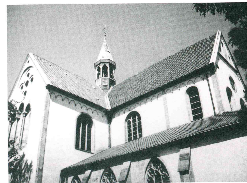
Abb. 9. Marienfeld. Ansicht von SO. Originales Obergadenfenster am Chorhalbjoch. Originalfenster des Südtranseptes, vergl. Ostfassade Torturm Rheda
