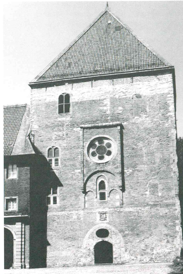
Abb. 7. Ansicht des Torturms Rheda von Osten (Burghof). Im 2. und 3. Geschoss liegt die Kapelle, eine Wohnebene im 4. Stock. Tor im Erdgeschoss vermauert
