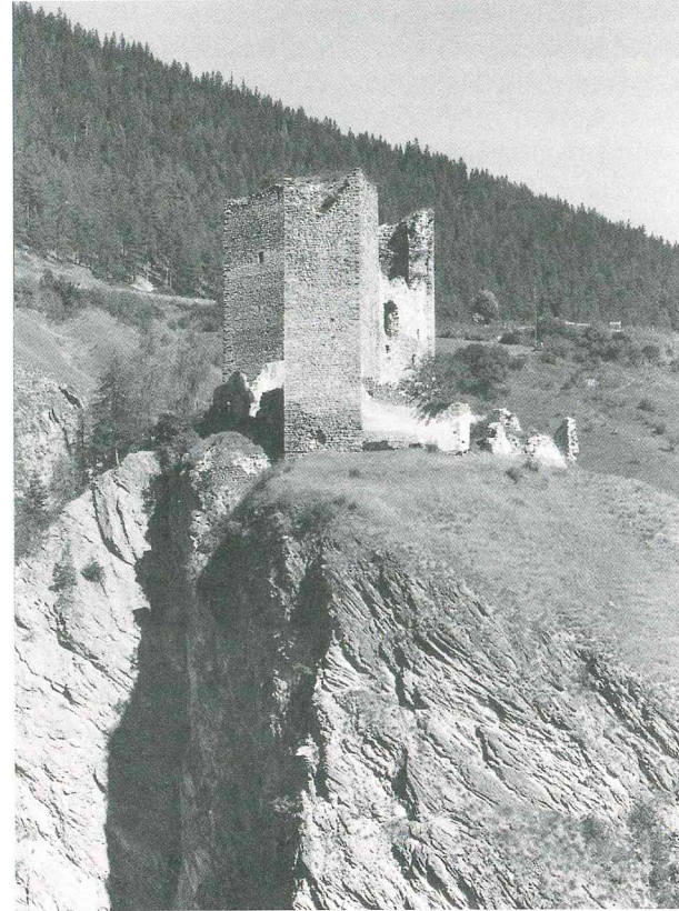
Abb. 12. Ramosch/Tschanüff. Da der mürbe Fels (links im Bild) abzustürzen drohte, musste die Burg im 18. Jahrhundert aufgegeben werden
