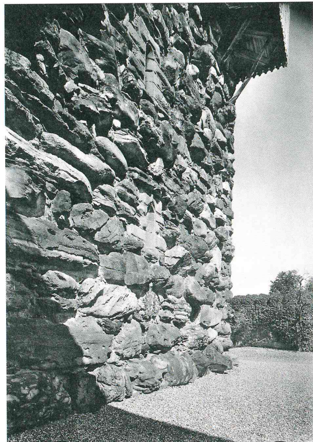
Abb. 8. Wohnturm der Burg Mammertshofen. Mauerwerk aus grossen, eiszeitlichen Findlingen ("Megalithturm")
