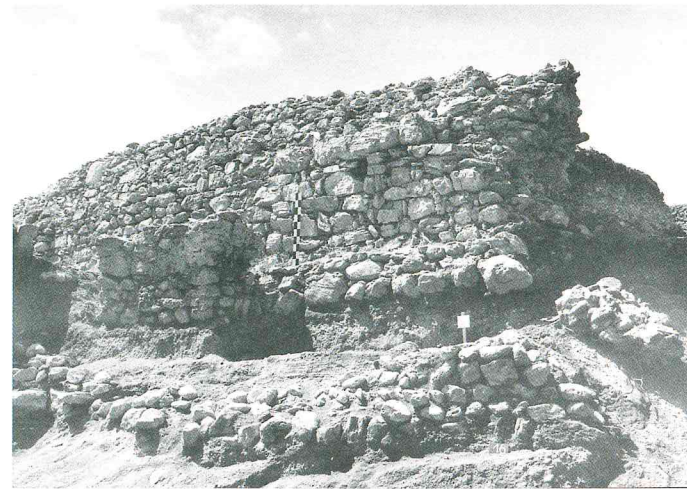
Abb. 4. Schiedberg während der Ausgrabungen 1968. Befestigungen auf dem rutschgefährdeten Kiezhügel seit dem 4. Jahrhundert nachgewiesen. Im Bild: Die an der Hügelkante errichtete Ringmauer musste wiederholt gestützt, verlegt und erneuert werden. Burg gegen 1400 nach Absturz der Nordhälfte aufgelassen
