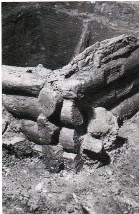
Rūmų D rūšio pamatų išorėje rasto kanalizacinio šulinio rentinio dalis
