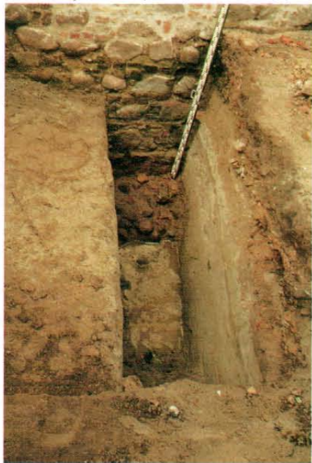
3 pav. Neries šlaito ties šiaurine gynybine siena sutvirtinimas akmenimis
