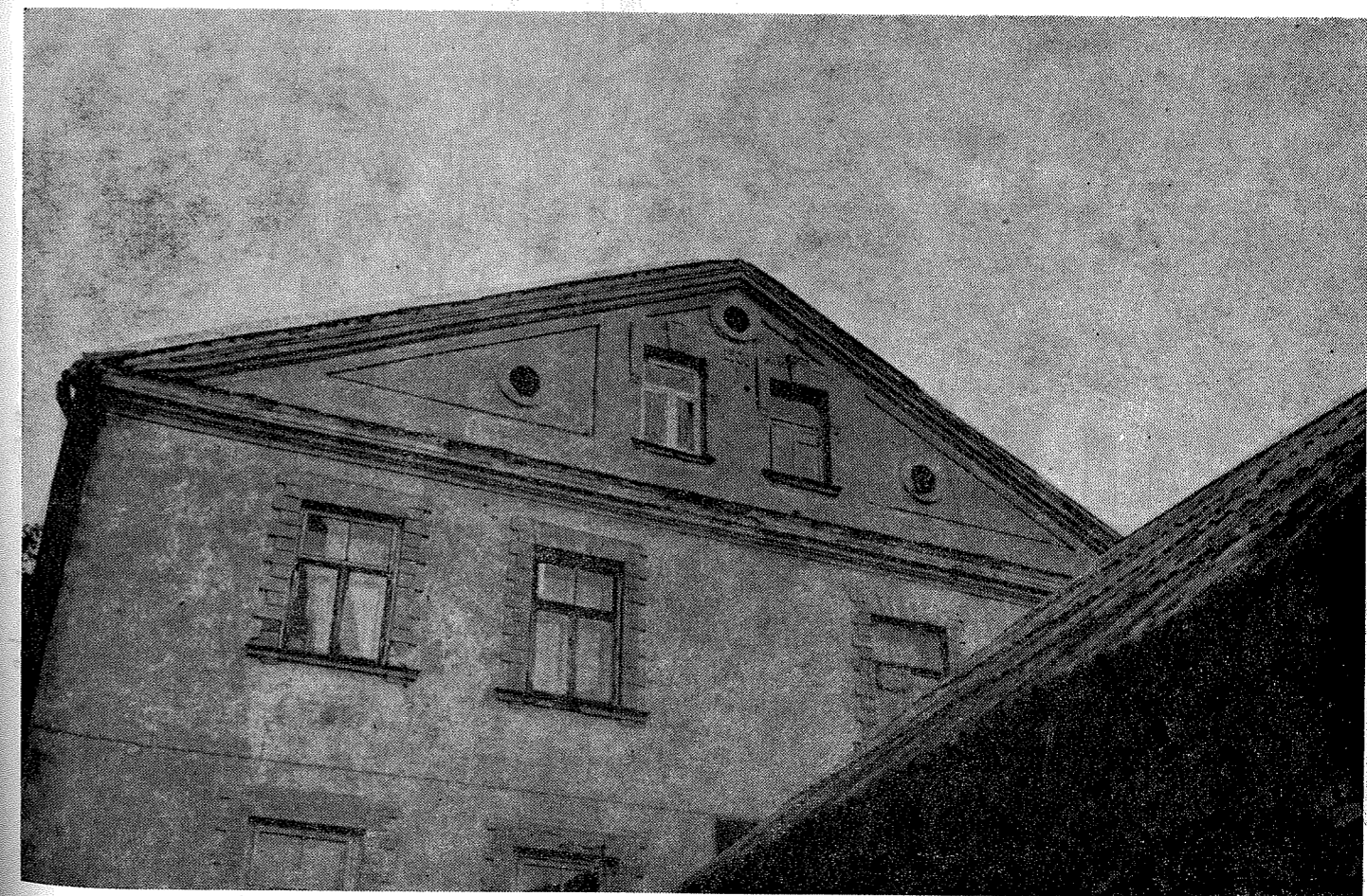
5 pav. 1906 m. rekonstrukcijos baigiamasis „akcentas“ — timpanas iš rytų pusės
