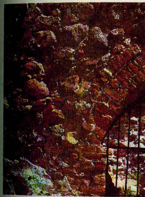
201 Aukštutinės pilies rūmų mūro technikos pavyzdžiai: gotikinio plytų mūro fragmentas, akmenų mūro fragmentas
