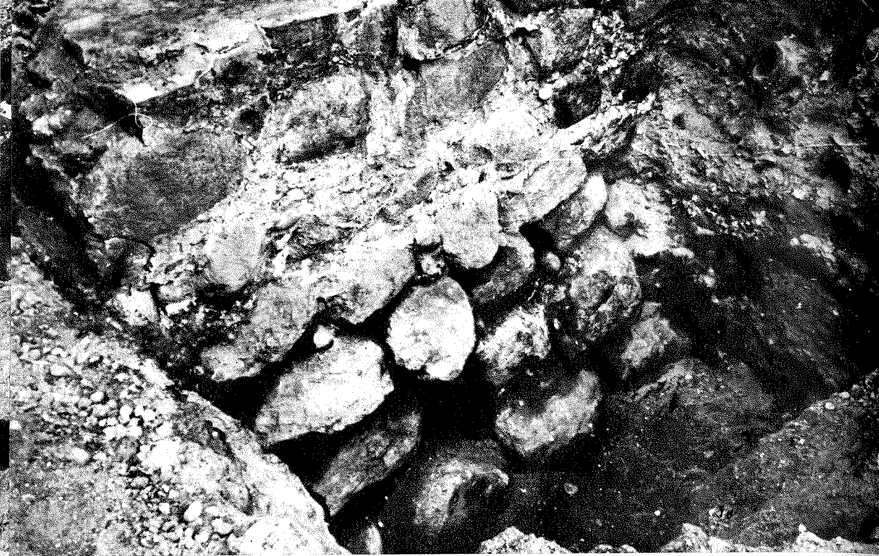
Klaipėdos pilies šiaurinio korpuso išorinės sienos pamatų detalė
