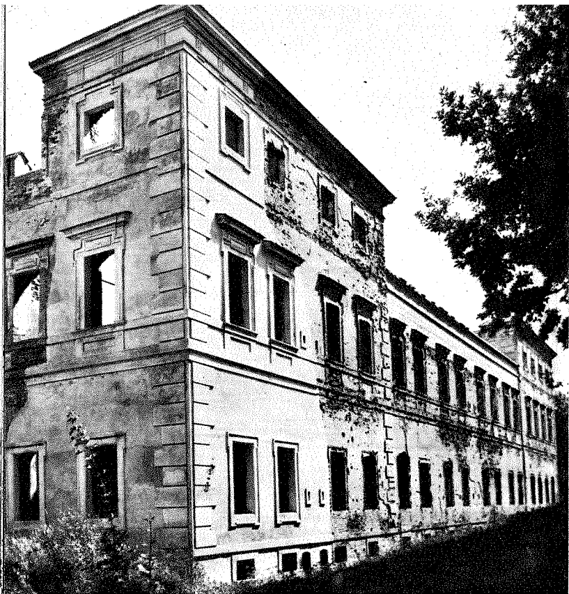
Konservuotos Biržų pilies pietinis fasadas
