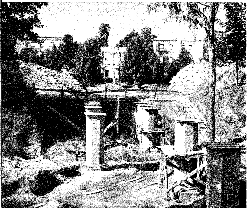
Biržų pilies tilto atstatymas
