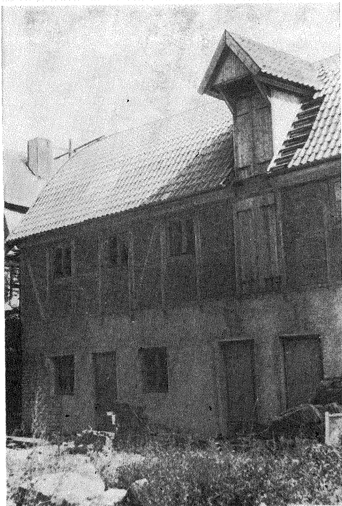
7 pav. Baigiamas restauruoti fachverkinis dviejų aukštų sandėlis Aukštosios g. Nr. 1 a
