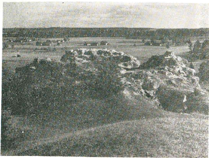
Liškiaivos pilies bokštas prieš restauravimą (Varėnos raj.)
